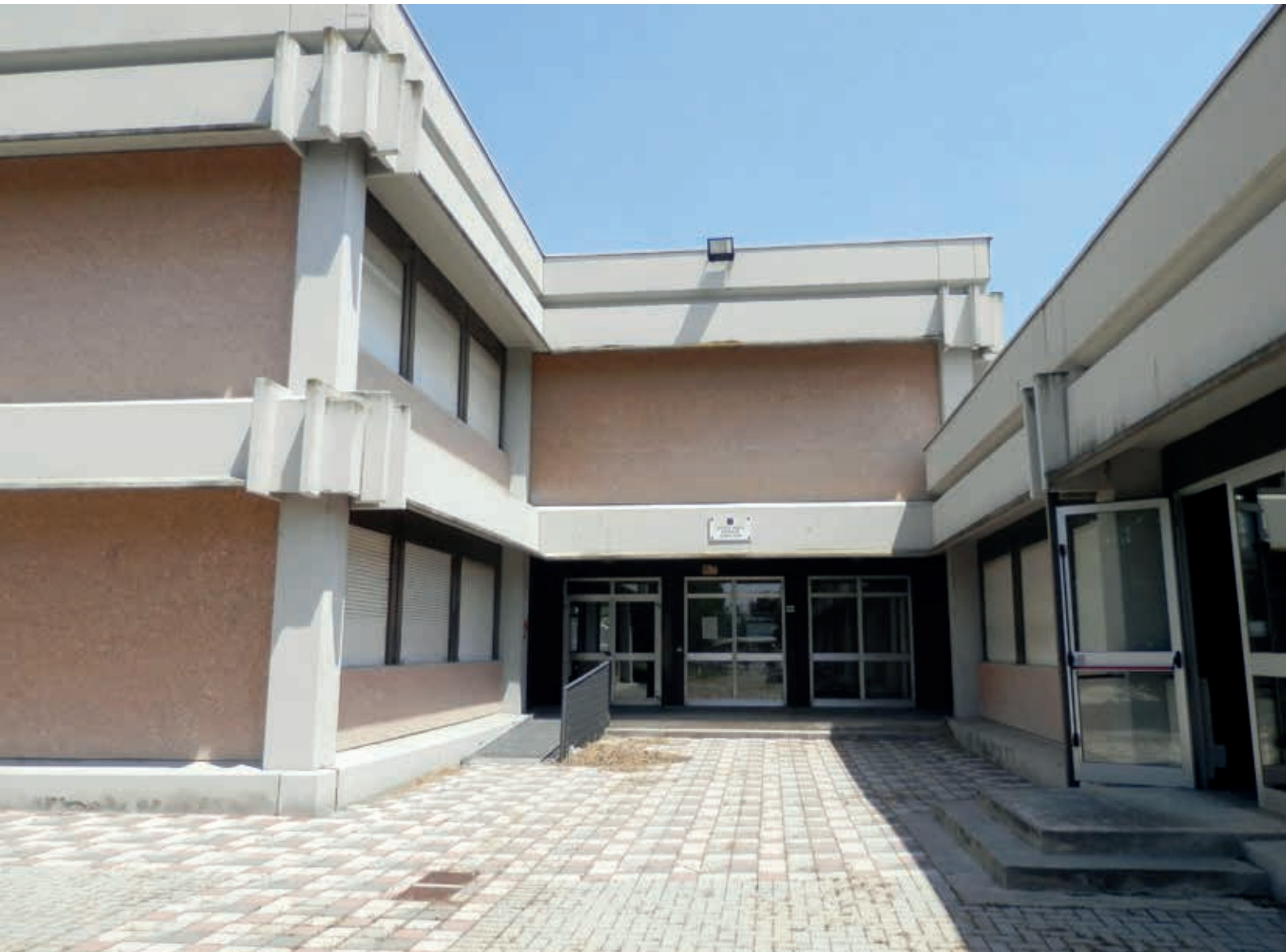
Ristrutturazione istituto comprensivo Sassi di Soliera
